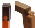
カマホゾ組 下への荷重強度が強い家作りに 使用される組立方法
