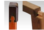
カマホゾ組 下への荷重強度が強い 家作りに使用される組立方法
