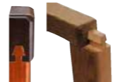
カムホゾ組 下への荷重強度が強い家作りに 使用される組立方法
